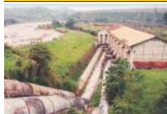
CENTRALE DE SANGA
